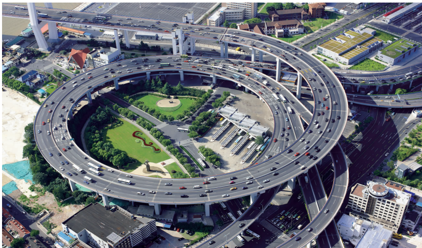
南浦大桥引桥
