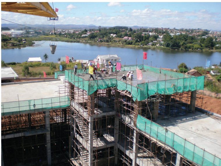
援马达加斯加国际会议中心主体结构封顶
