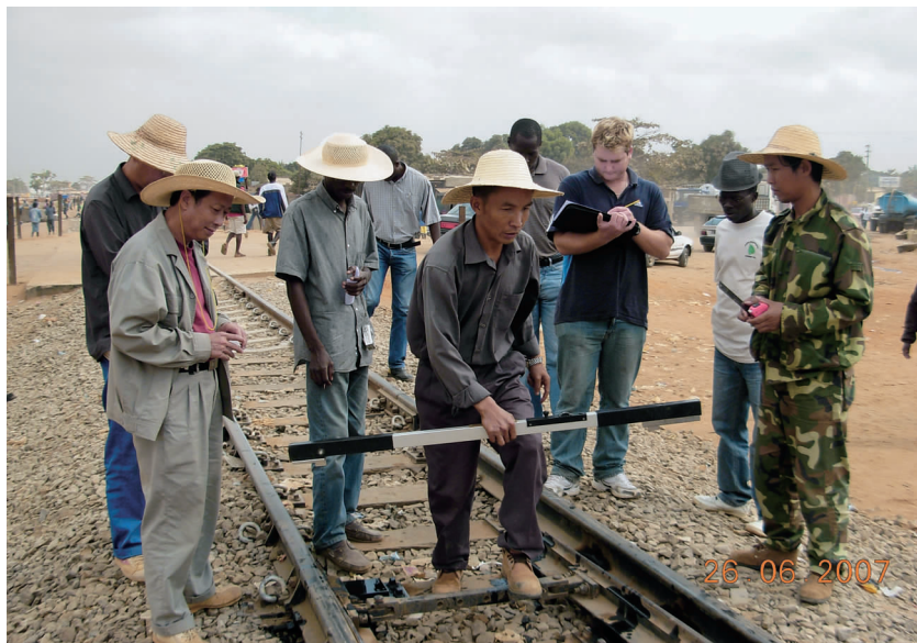
中铁公司安哥拉铁路施工现场
