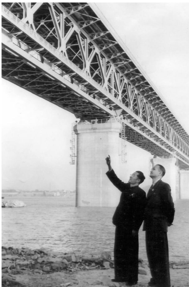
西林和彭敏视察正在建设中的武汉长江大桥
